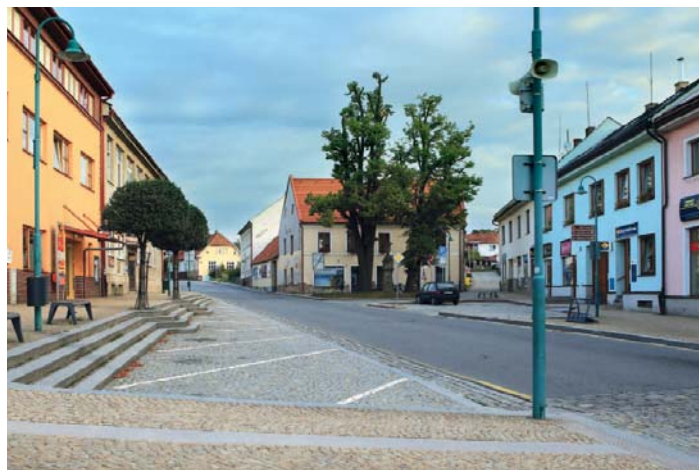
Vlevo budova nové bystřické pošty. Za ní budova bývalého Svazarmu (Svaz pro spolupráci s armádou). Napravo září nové fasády domů uzavírající bývalé horní náměstí.
