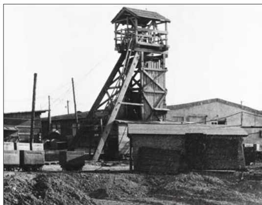
Prozatímní dřevěná těžní věž na šurfu č. 13 (později nahrazena jámou R I)
