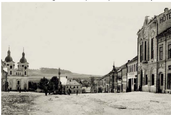
Pohled na dolní náměstí z tzv. horního náměstí. Zřetelně vidíme strmě klešající zástavbu na pravé straně. Pravé straně dominuje hotel Záložna. Nalevo kostel sv. Vavřince. Foto H. Jeřábek, 1930.
