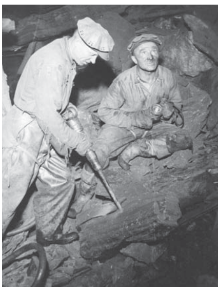
Taktéž na oběhu vozíků převažovala práce rukou. Vrcholem mechanizace mimo lopaty a gracky byla ruční pneumatická sbíječka
