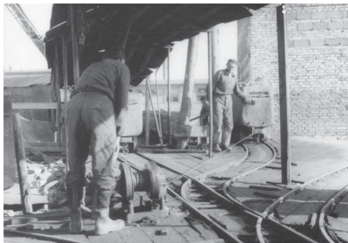
Důlní vozíky se do těžních klecí narážely ručně
