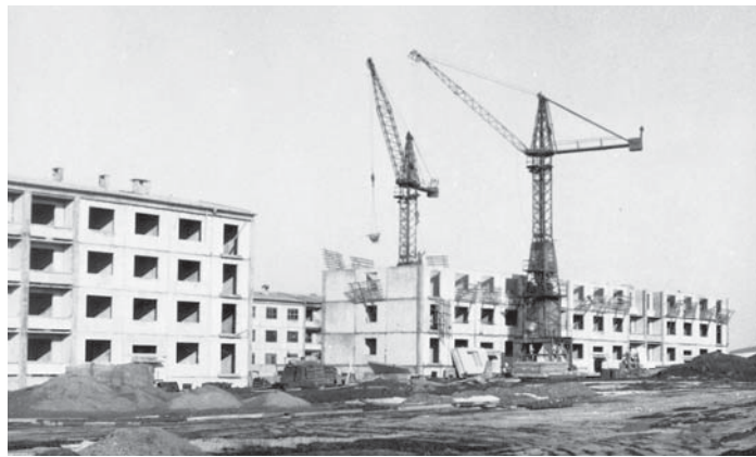
Stavba panelových domů na sídlišti I. v Bystřici
