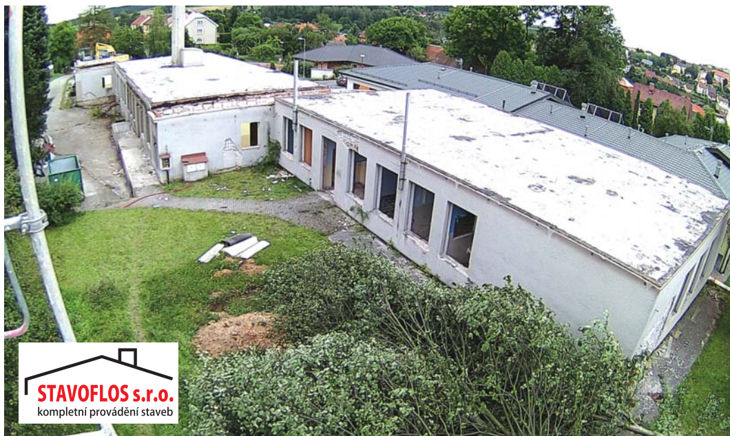
Současný stav: probíhající demolice bývalé MŠ Korálky
