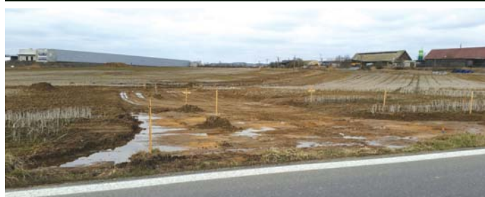
V průmyslové zóně se již intenzivně pracuje. Na obrázku je vidět budoucí silnice, na které byla provedena skryvka ornice.
