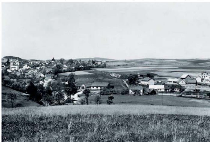
Pohled na město od východu. Vlevo Staré město, vpravo poměrně rozlehlá čtvrť – Na Cihelně s provozními budovami městské cihelny.
