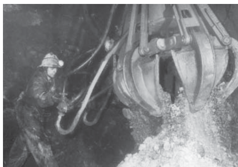
Hloubení jámy R VIIS
